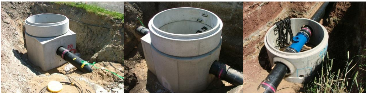
Ausschnitt der Rohrverlegung
