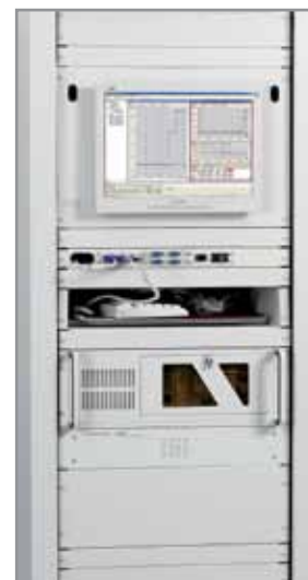
Installation du poste en intérieur
