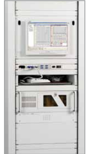
실내 선반 설치
