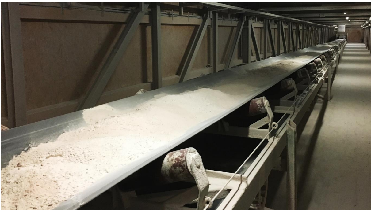
Salz Förderband in Betrieb im Werk Zielitz
