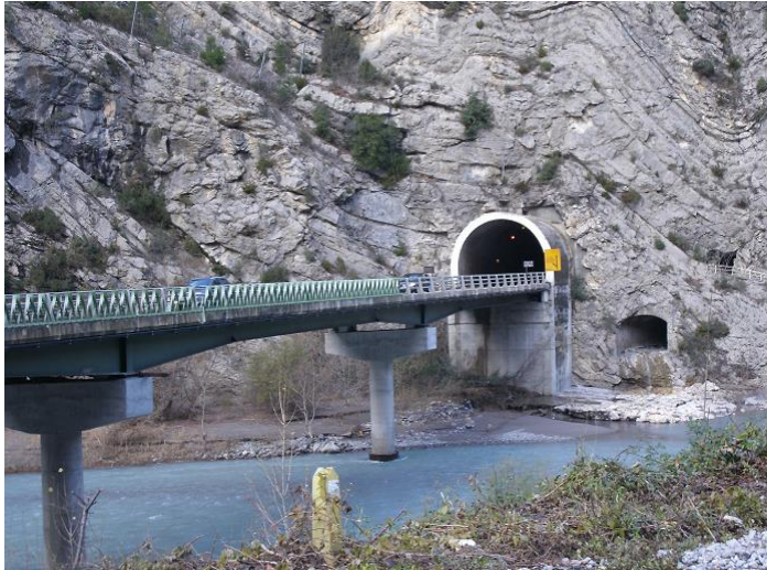
Tunnel de la Mescla
