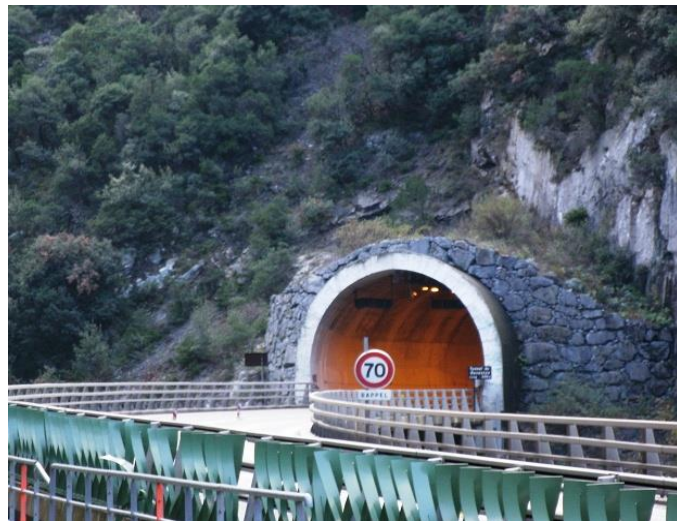
Tunnel du Reveston
